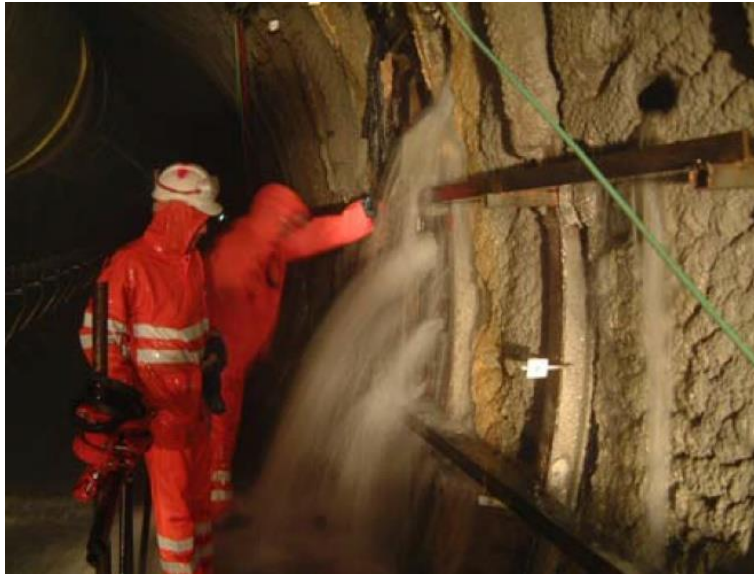
Abbildung 3. Signifikante Wasserzutritte (100 l/s).
