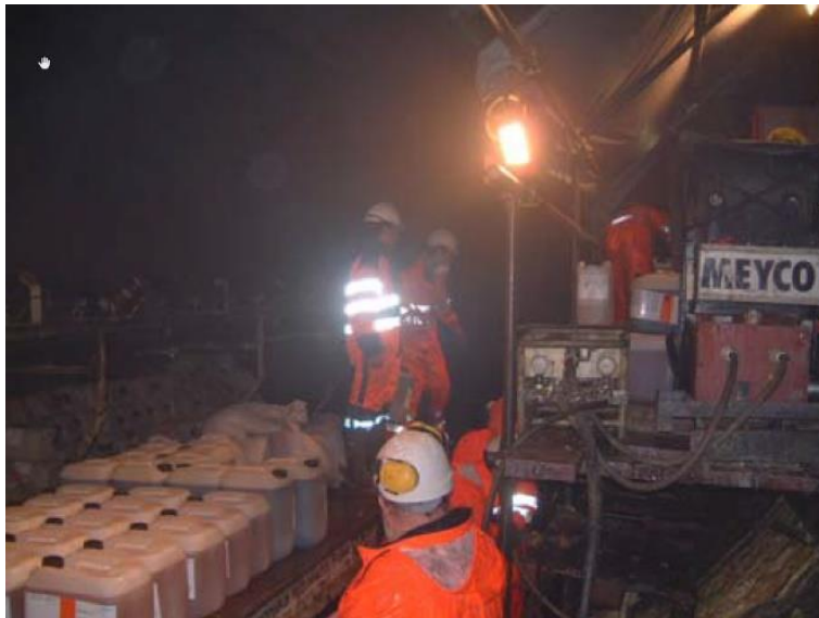
Abbildung 4. Injektionssetup für 2 K PU System (Pumpe /Heizer).
